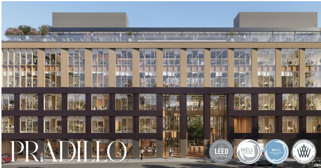
Imagen: Fachada Edificio Pradillo
